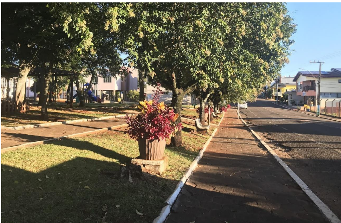
Figura 17 - Passeio com pavimentação de qualidade e sem acessibilidade
