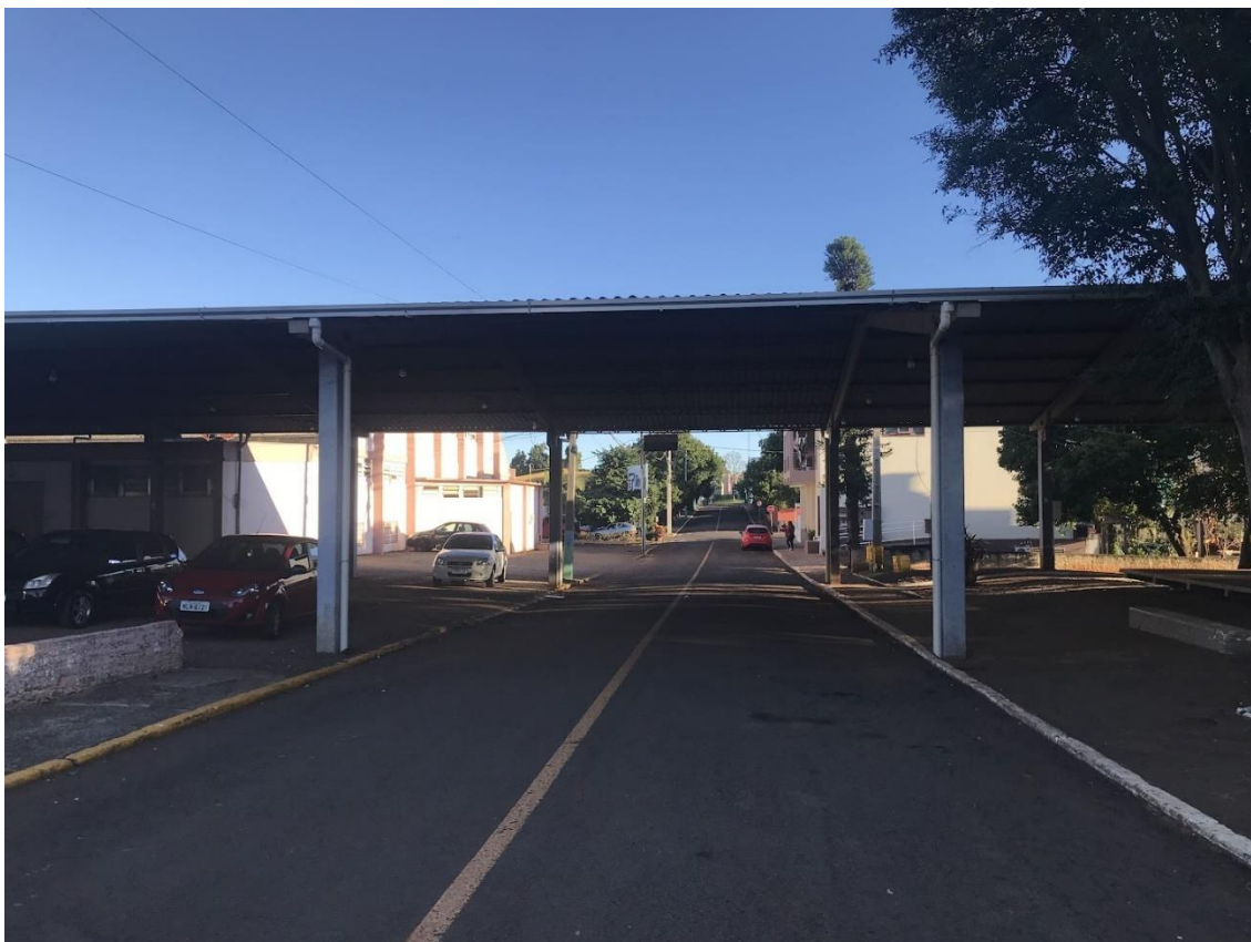
Figura 38 - Cobertura na Rua Assis Brasil
