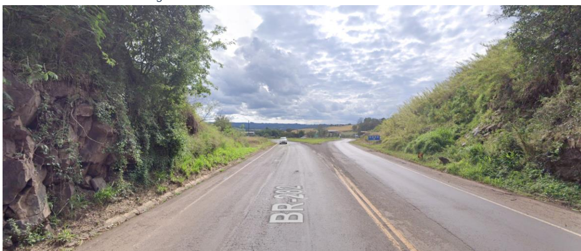
Figura 19 - Acesso Pela BR-280 - Distrito de Juvêncio
