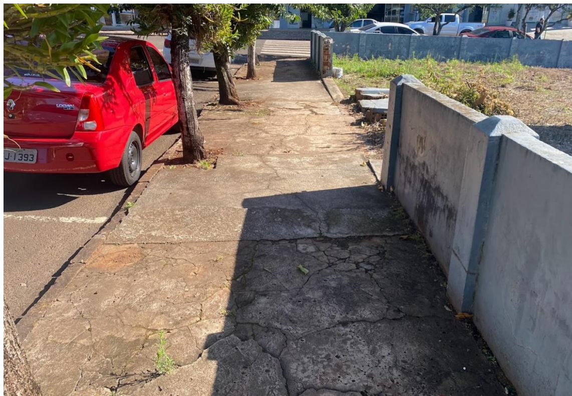
Figura 43 - Passeio com boa pavimentação e sem acessibilidade
