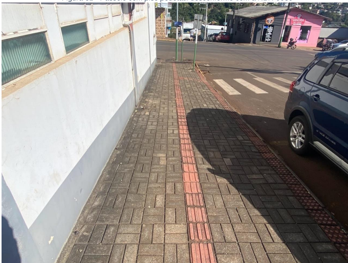
Figura 51 - Passeio com piso podotátil desconforme com a NBR-9050
