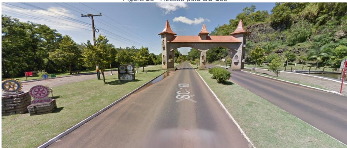
Figura 18 - Acesso pela SC-160
