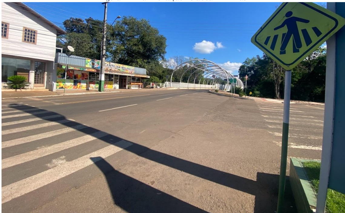
Figura 24 - Pavimentação Asfáltica - Av. Brasil
