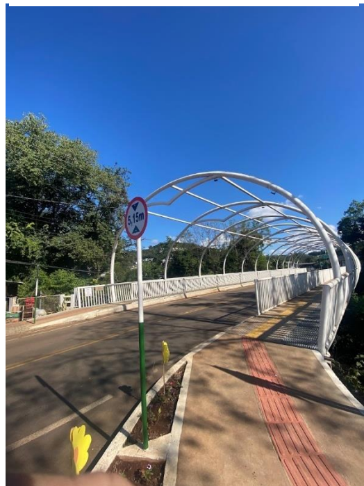
Figura 8 -Ponte sobre o Rio Saudades
