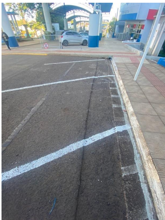
Figura 34 - Sinalização Horizontal Estacionamento Oblíquo
