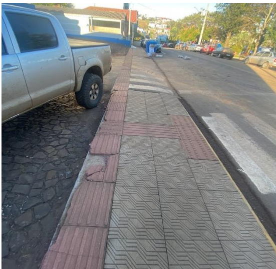
Figura 43 - Passeio desconforme com a NBR-9050
