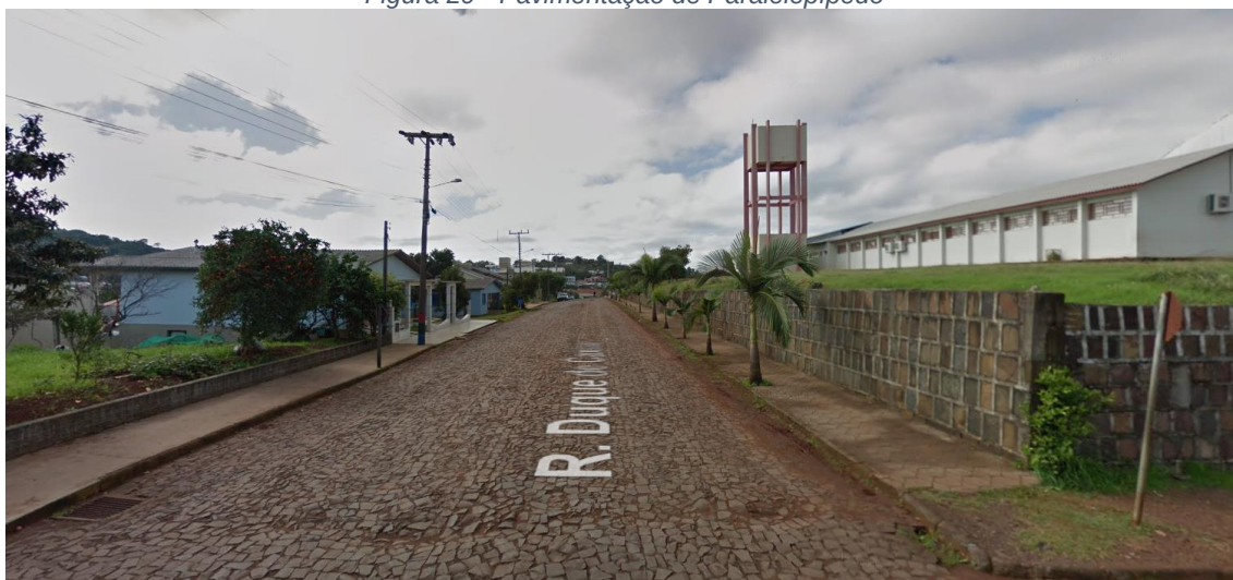
Figura 29 - Pavimentação de Paralelepípedo
